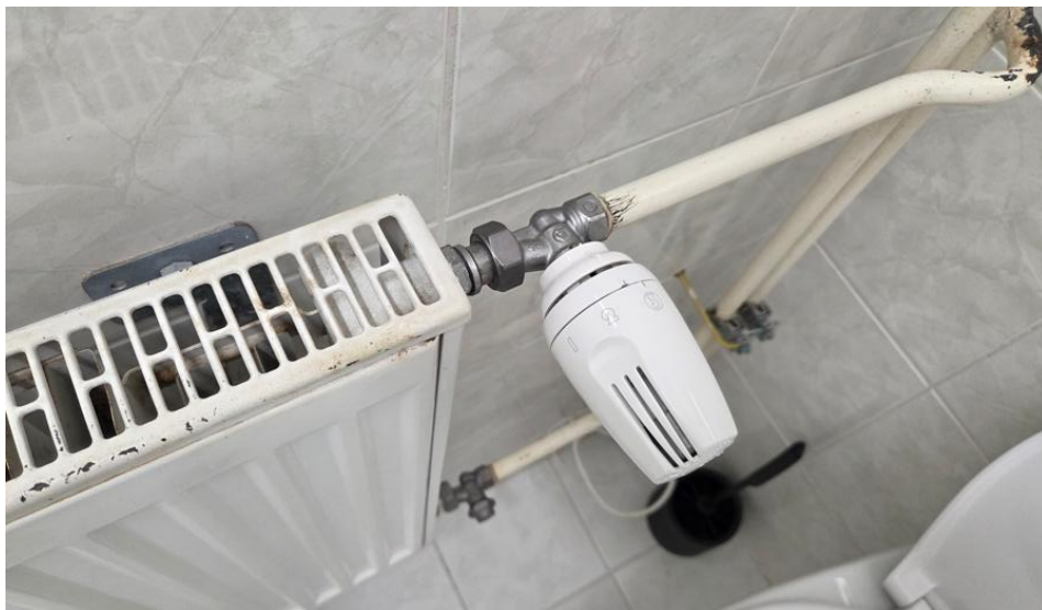
Foto stávajících TRV ventilů ilustračně
