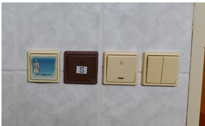
Foto sestavy vypínačů – dva po levé straně ke zrušení
